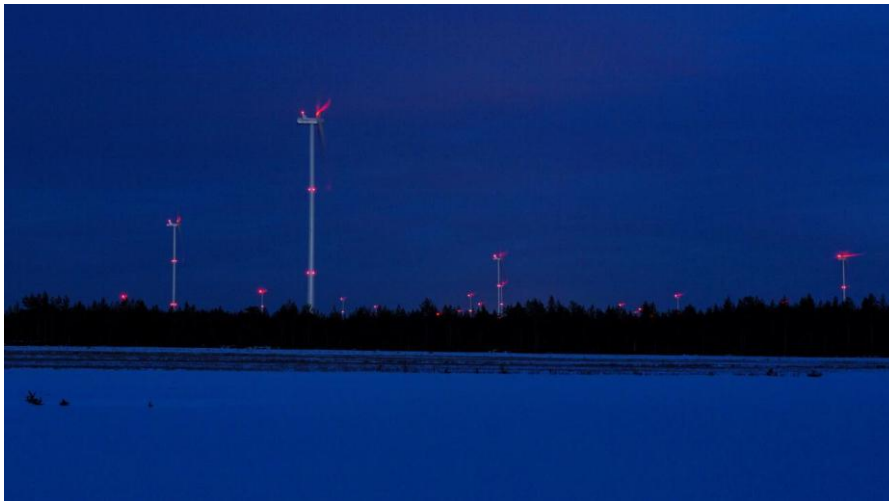
Kuva 126. Kiinteät punaiset lentoestevalot pimeällä. (Kuva: FCG)
