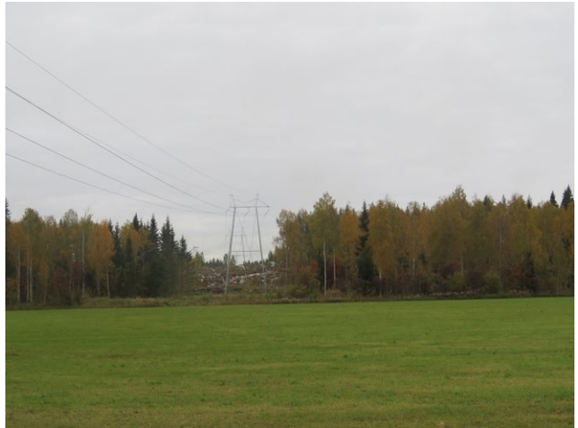
Kuva 20. Linjaus Harjunpäästä pohjoiseen.
