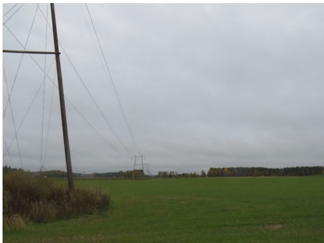
Kuva 25. Linjaus Laitakankaan kohdalla koilliseen
