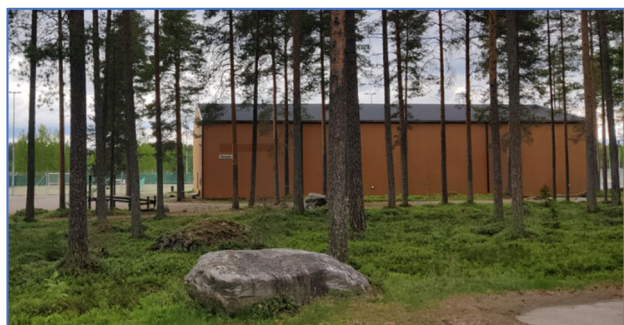
Kuva 8. Tennishalli alueen pohjoisosassa, Kitinrivin parkkipaikalta päin kuvattuna. © Plandea
